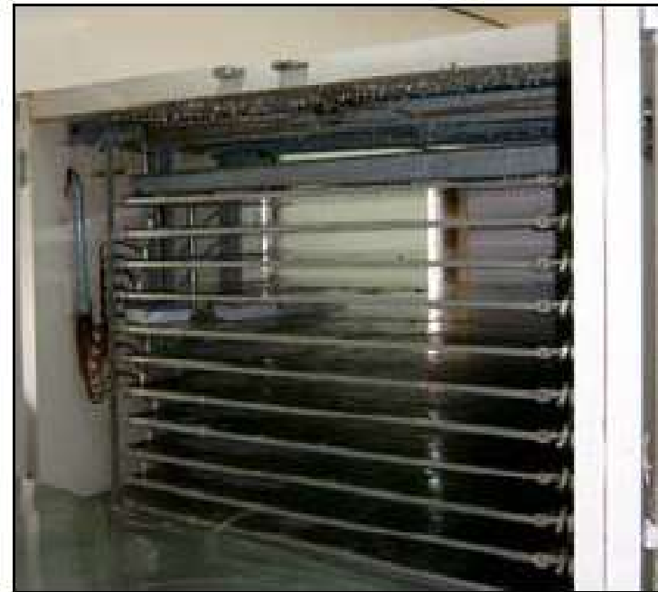
รูปที่ 2-8.6 เครื่องระเหยสารทำความเย็น
