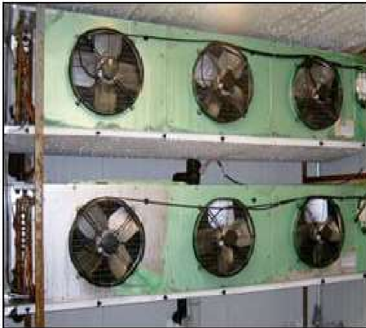
รูปที่ 2-8.6 เครื่องระเหยสารทำความเย็น
